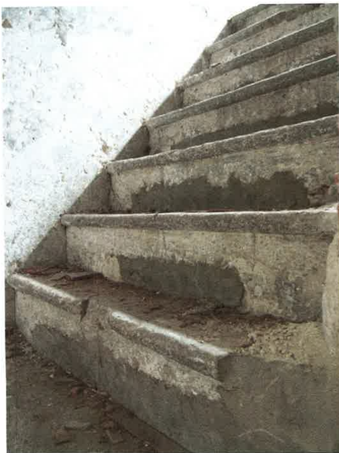
Schody do podkrovia :
