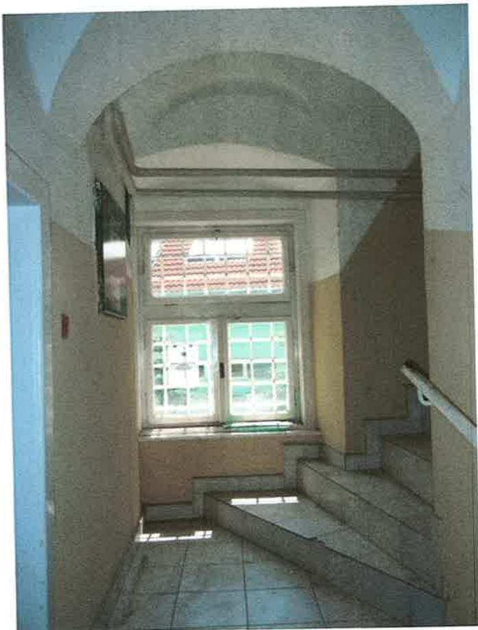
Foto č. 33 : Severné krídlo, bočné schodisko
