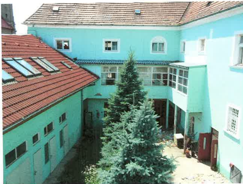
Foto č. 9 : Pohľad na dvorové fasády západným smerom
