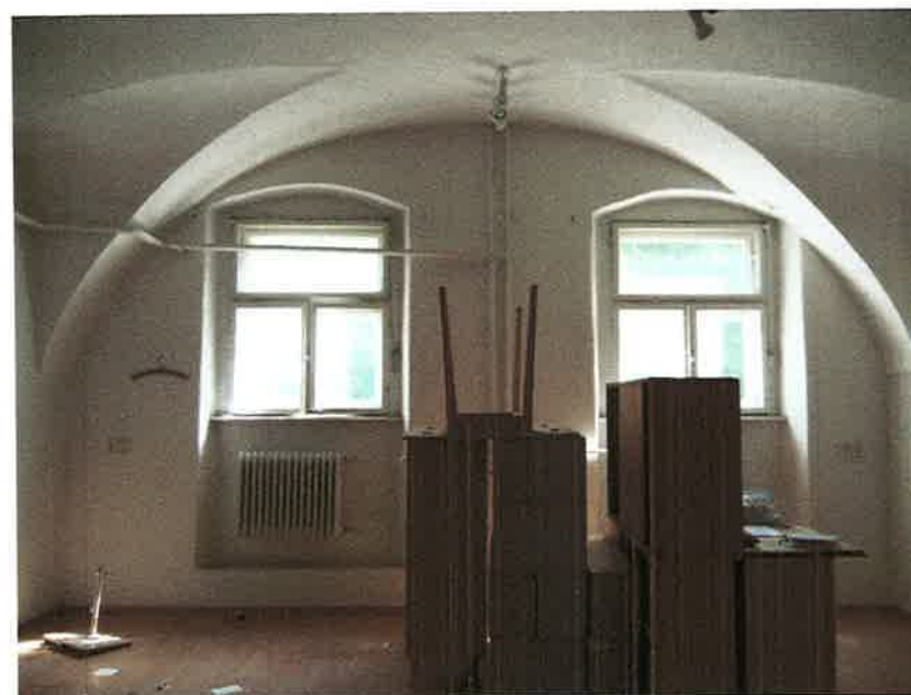
Foto č. 14 : Východné krídlo, 1.NP, m.č. 1.06, východná stena
