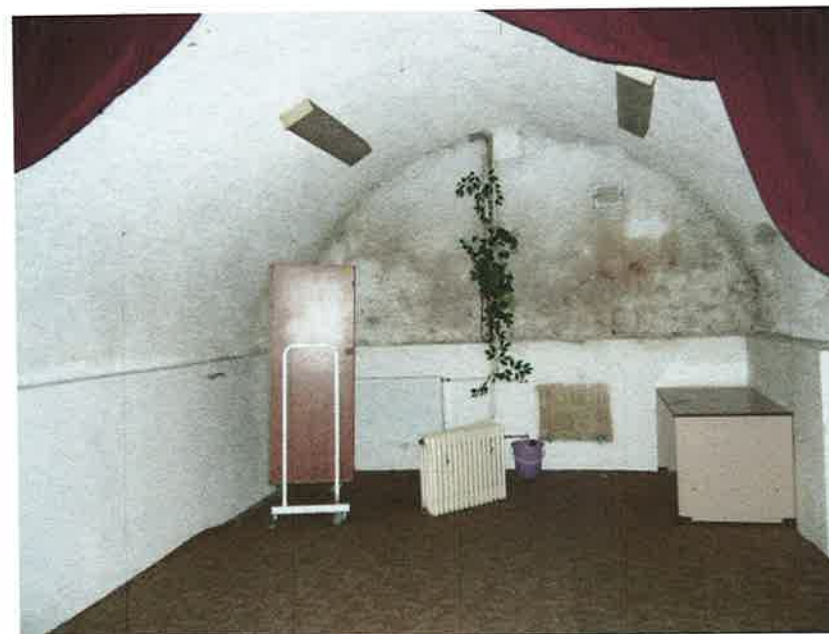
Foto č. 36 : Severné krídlo, pivnica č. -1.11, pohľad východným smerom
