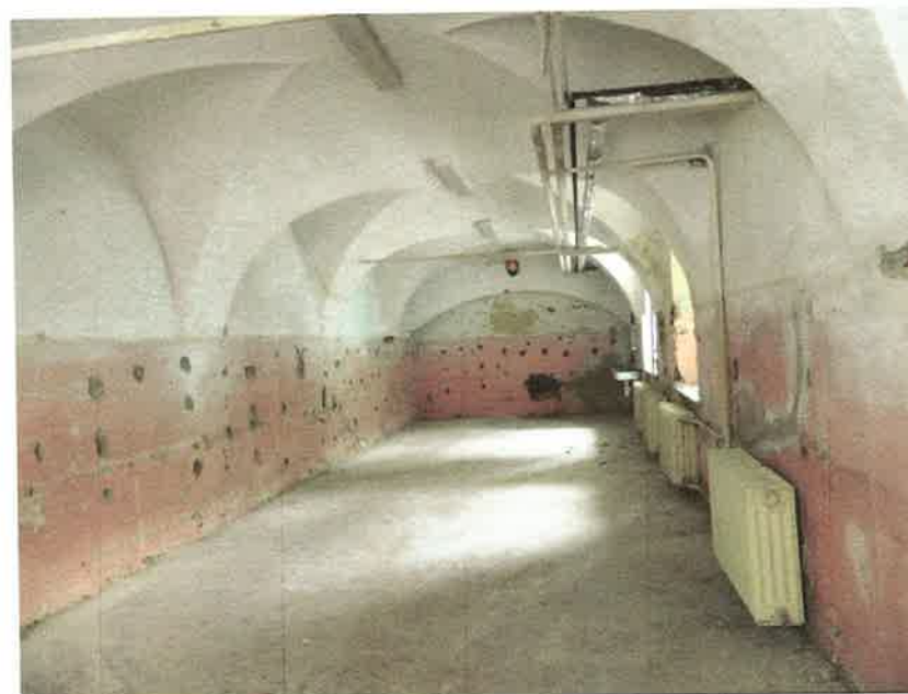
Foto č. 22 : Severozápadná m.č. 1.26, 1.NP, pohľad východným smerom
