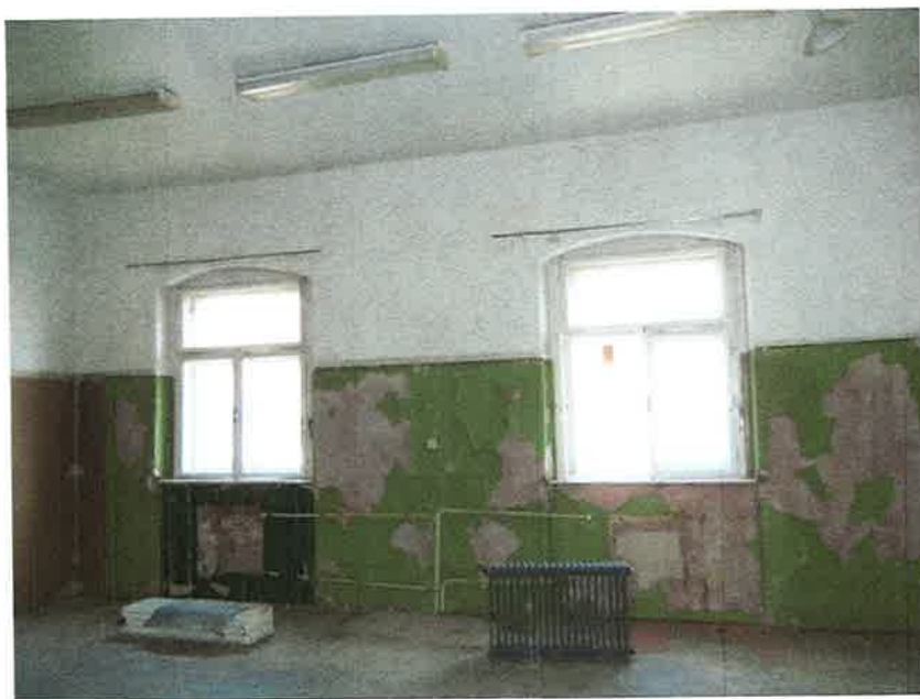
Foto č. 27 : Východné krídlo, 2.NP, m.č. 2.11, východná stena
