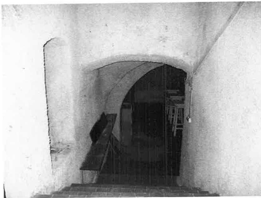
Foto č. 37 : Kolmé krídlo, pivnica č. -1.02, pohľad zo schodiska západným smerom
