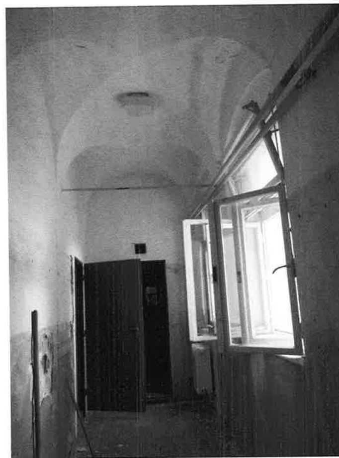
Foto č. 24 : Východné krídlo, 2.NP, chodba č. 2.02, pohľad smerom k juhu
