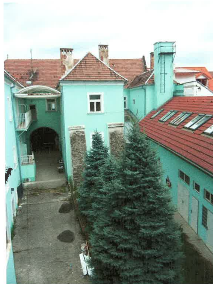
Foto č. 4 : Pohľad na dvorové fasády východným smerom
