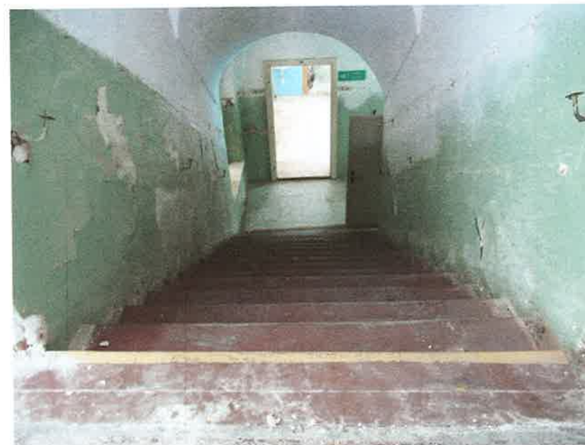
Foto č. 32 : Kolmé krídlo, hlavné schodisko, horné rameno, pohľad dolu na medzipodestu
