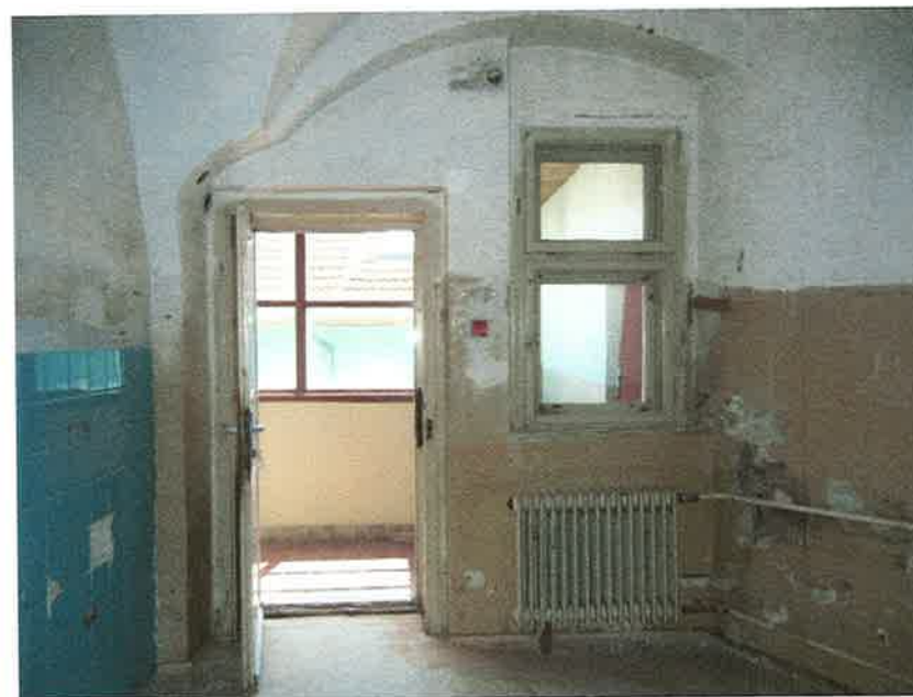
Foto č. 28 : Severozápadná m.č. 2.26, 2.NP, južná stena
