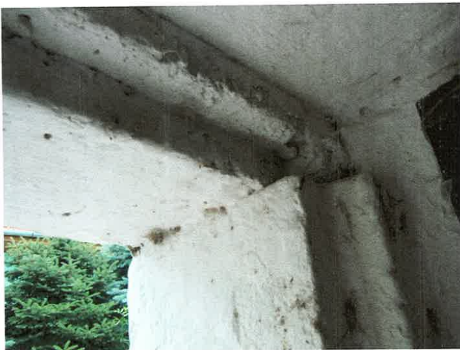
Detail : Pravouhlý ozub na vnútornej hrane kamennej obruby :
