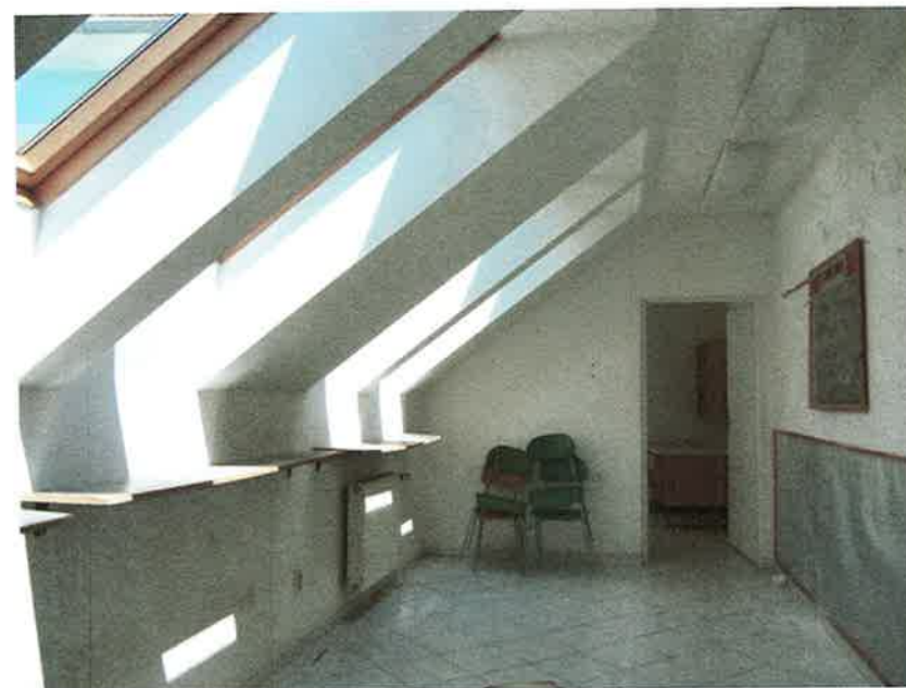
Foto č. 30 : Južné krídlo, 2.NP, m.č. 2.36, východný pohľad
