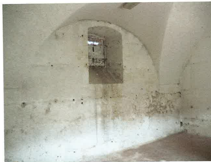
Foto č. 20 : Severné krídlo, m.č. 1.24, 1.NP, severná stena
