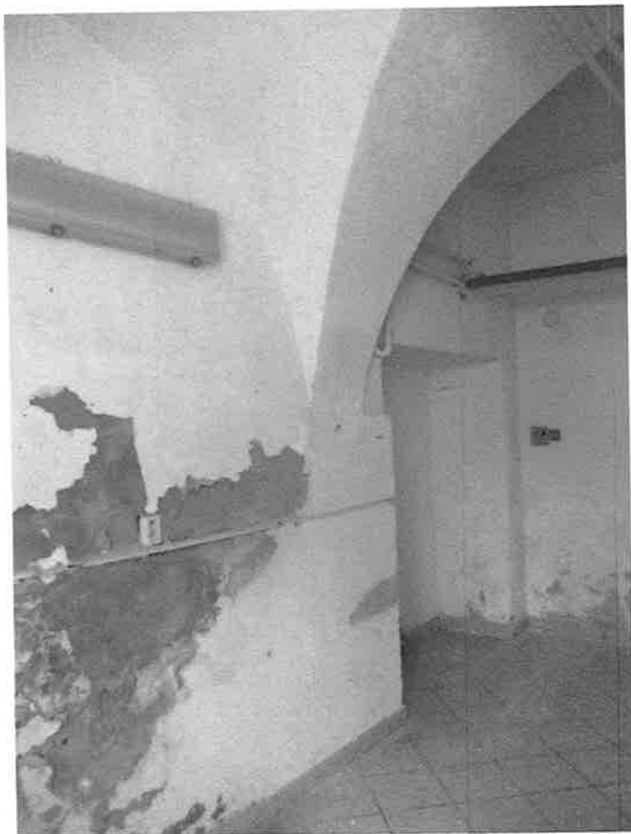
Foto č. 23 : Juhozápadná m.č. 1.26, 1.NP, pohľad severovýchodným smerom
