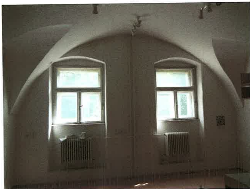
Foto č. 13 : Východné krídlo, 1.NP, m.č. 1.05, východná stena
