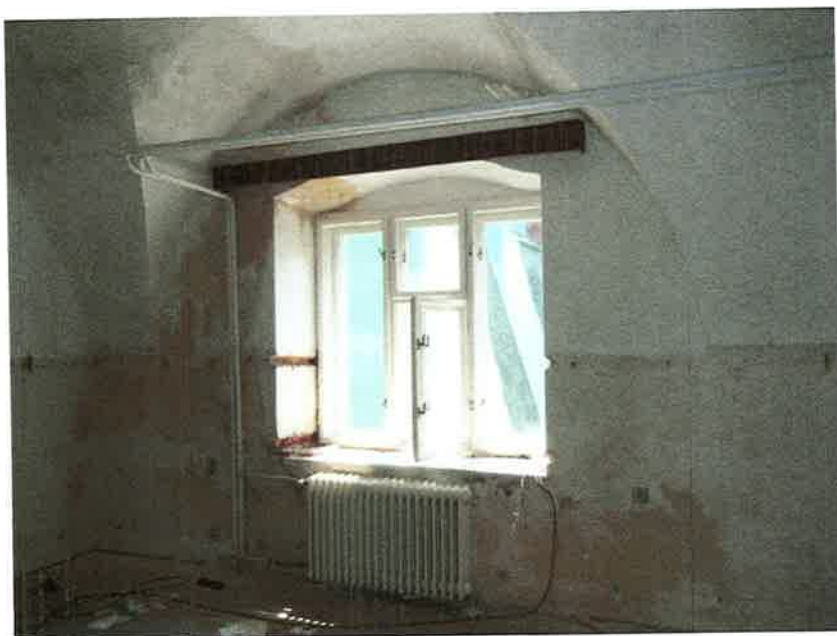
Foto č. 19 : Severné krídlo, m.č. 1.22, 1.NP, pohľad juhovýchodným smerom
