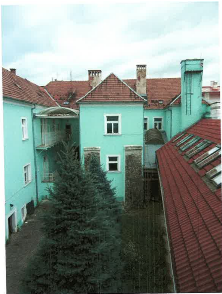
Foto č. 5 : Pohľad na dvorové fasády východným smerom
