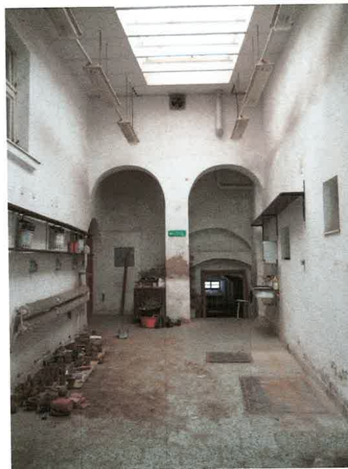
Foto č. 16 : 1.NP, priestor č. 1.10, pohľad východným smerom
