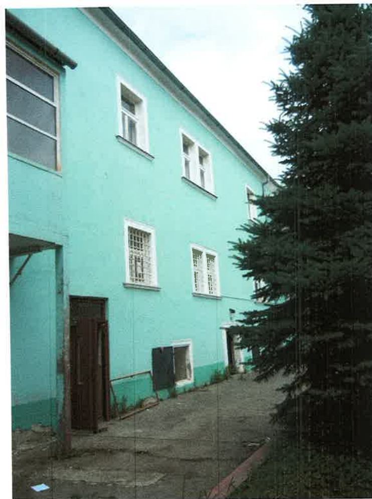
Foto č. 6 : Pohľad na dvorovú fasádu severného krídla severovýchodným smerom
