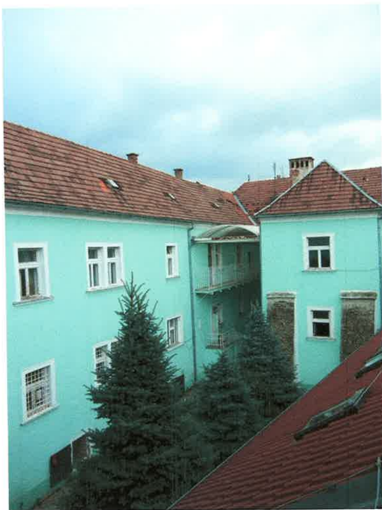
Foto č. 3 : Pohľad na dvorové fasády východným smerom
