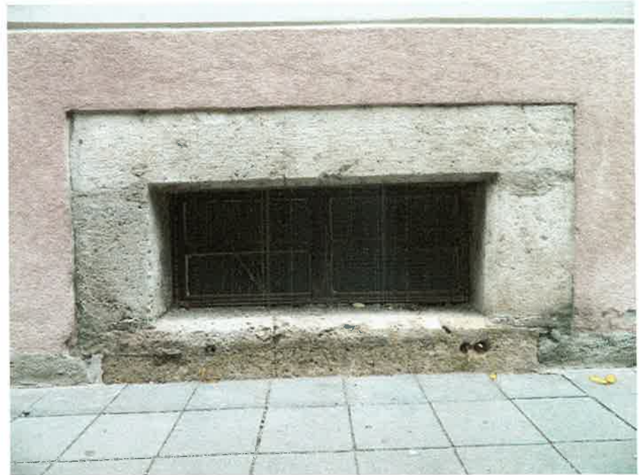
Štvrté pivničné okno :
