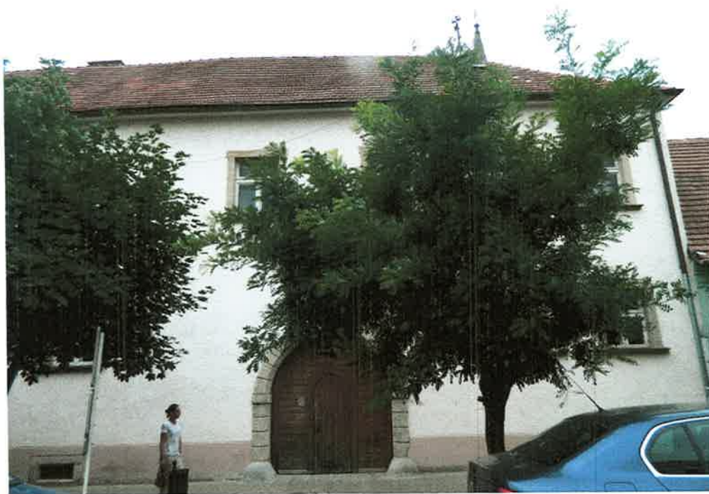
Foto č. 1 : Fasáda objektu z ul. M.R. Štefánika
