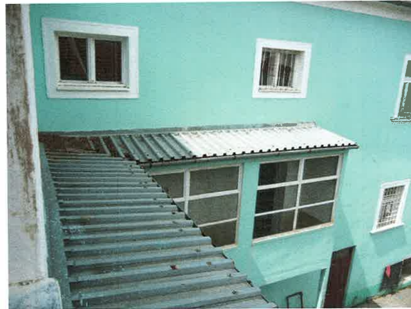
Foto č. 10 : Dvorová fasáda severného krídla, západná časť
