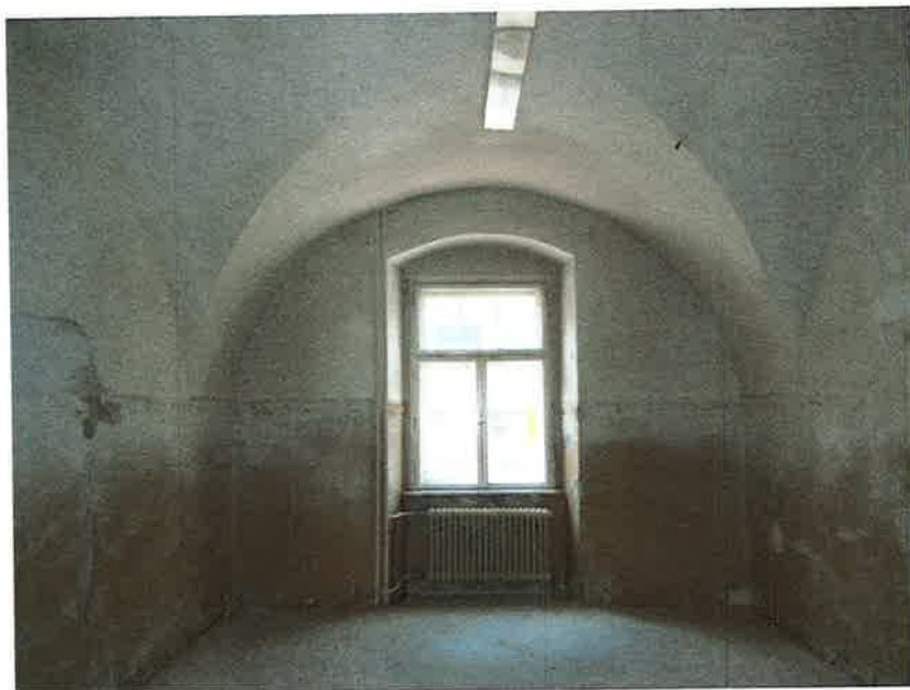
Foto č. 29 : Západné krídlo, 2.NP, m.č. 2.27, západná stena
