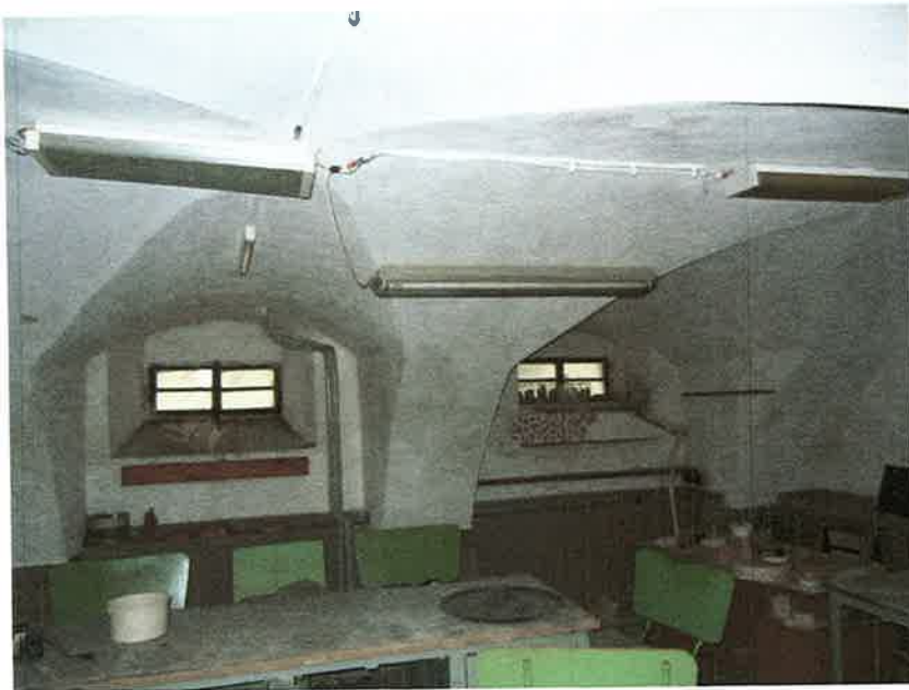
Foto č. 35 : Východné krídlo, pivnica č. -1.04, pohľad východným smerom
