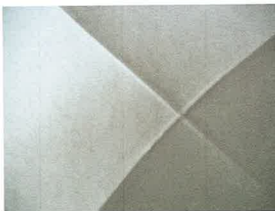
Hrebienky na klenbe schodiska č. 1.01 a 2.01 :
