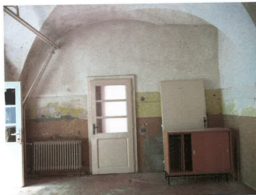
Foto č. 18 : Severné krídlo, m.č. 1.17, 1.NP, pohľad západným smerom
